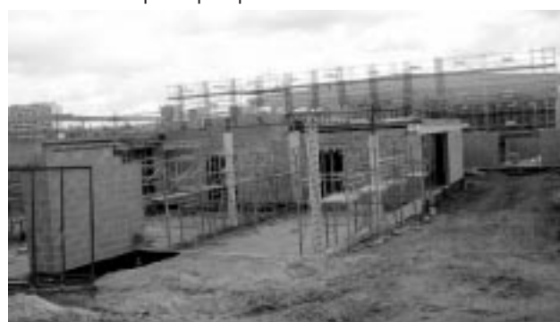
Le centre sportif en construction.
