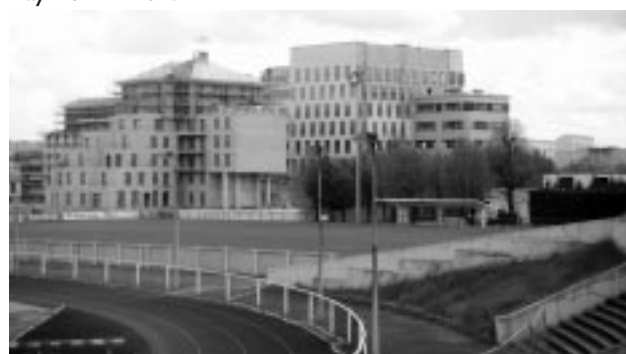
Deux bâtiments privés presque finis.
