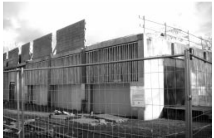
Le gymnase en démolition.
