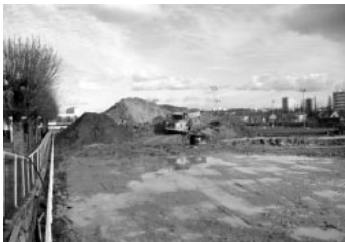
Le terrain de rugby en démolition.
