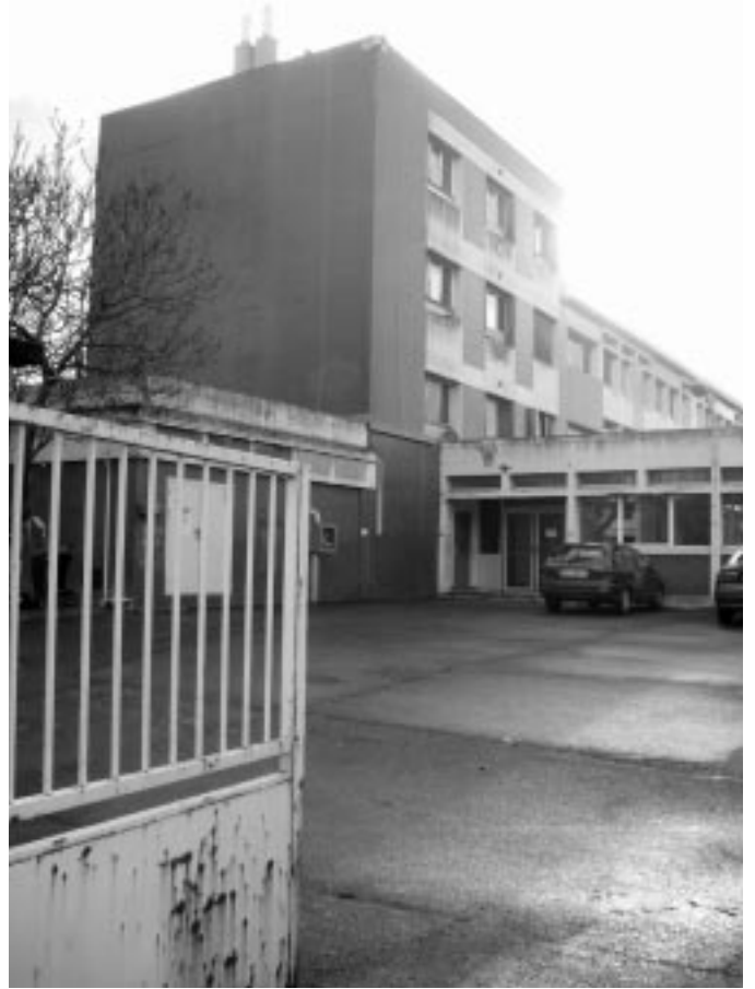
Les bâtiments de l'ancien LEP.
